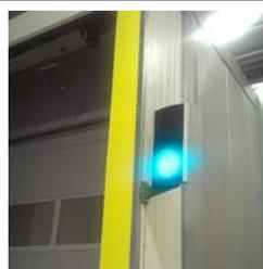
Присутствие автомобиля контролируется светофором с помощью датчика, расположенного над перегрузочным мостом или в тормозной колодке.
